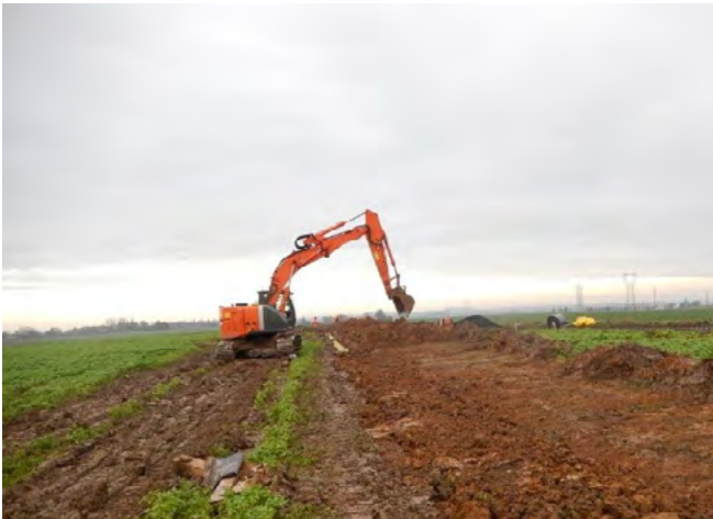
Figure 46 – Le remblaiement et la remise en état
