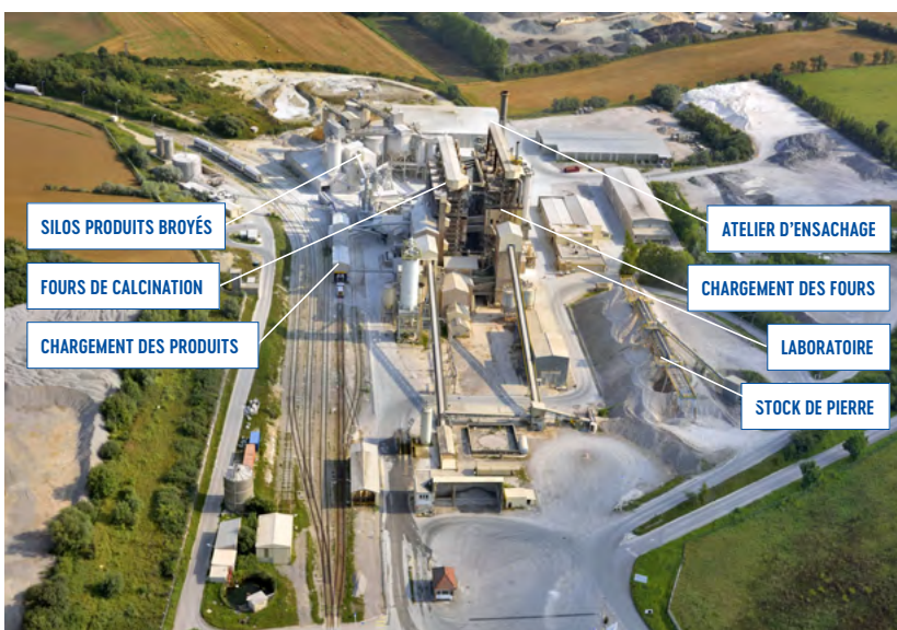
Figure 31 - L'usine de Réty et ses installations
