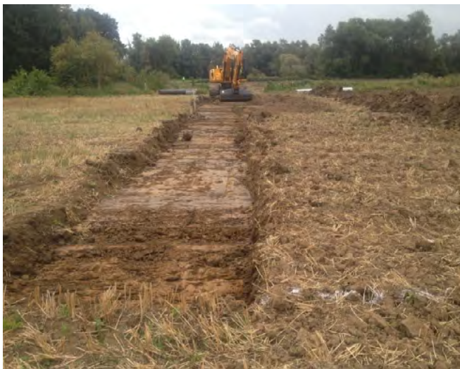
Figure 45 – L'ouverture de la canalisation et la mise en fouille
