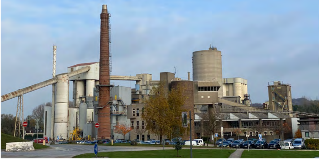
Figure 9 La cimenterie de Lumbres
